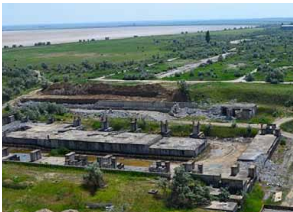
Рис.10 Фундамент второго энергоблока КАЭС
